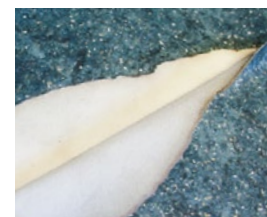
Delaminierung nach Überbeanspruchung durch Stuhlrollen
