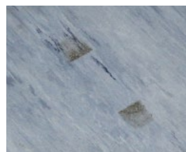
Verfärbung und Eindrücke durch ungeeignete Rollen
